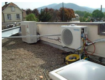
Sur le toit derrière un mur acrotère
