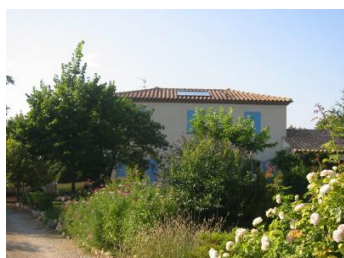
Discret en façade vue de la rue
