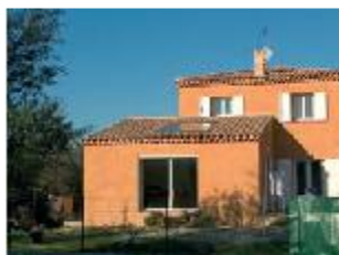
Intégré à la toiture de l'extension
