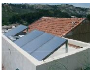
Derrière un mur acrotère en toiture
